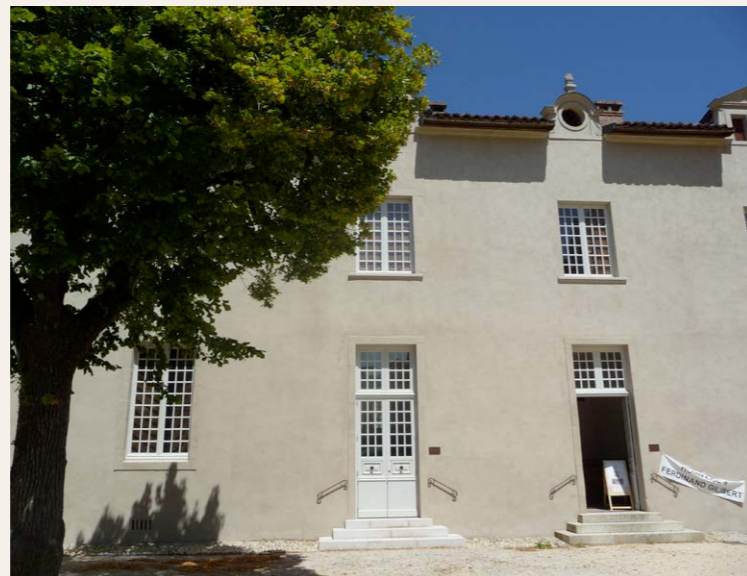
Façade enduite. Référence à reproduire en cas de rénovation future d'autres façades
